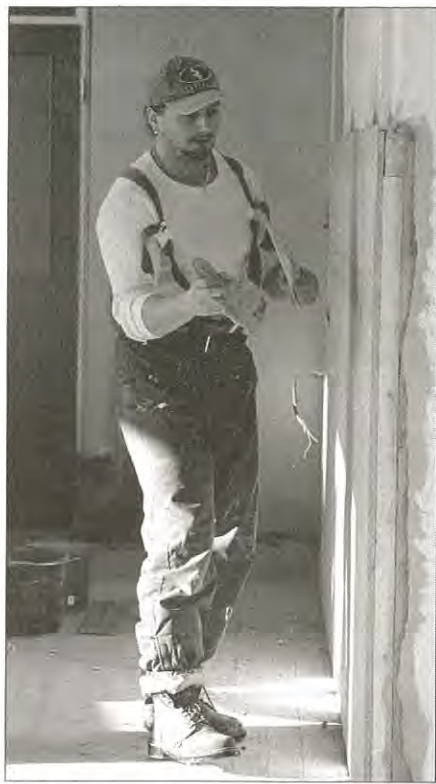
Peter Rundgren spacklar en vägg inne på det blivande Bygget.
