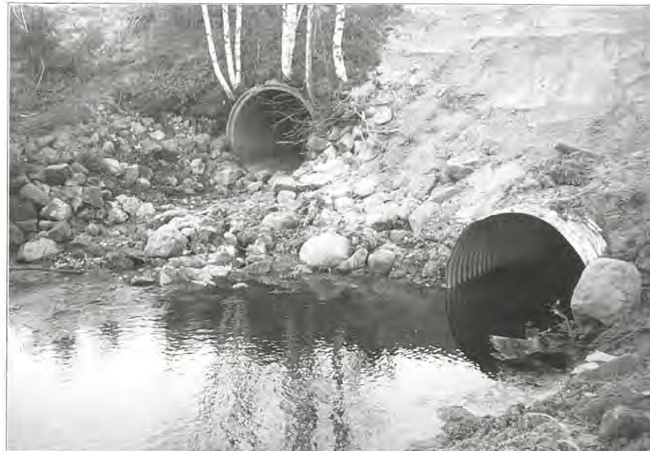
Rätt utförd återställning av Kvarnbäcken, i Mårdsel, på Gällivare Allmänningsskogas marker. Foto; Lennart Björk.
