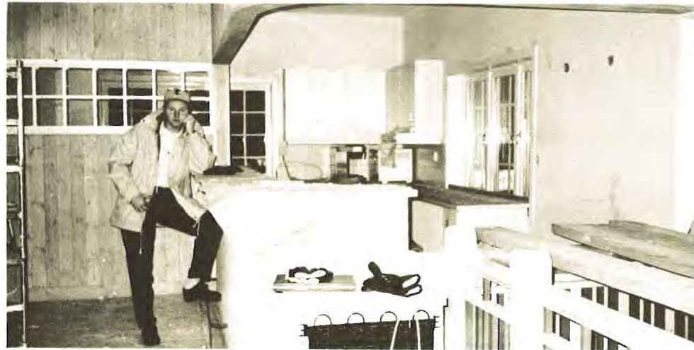
BLIVANDE FIK. Jonas Lundmark poserar framför den bardisk som kommer att flankera det blivande caféet på Ungdomens Hus, Stacken.
