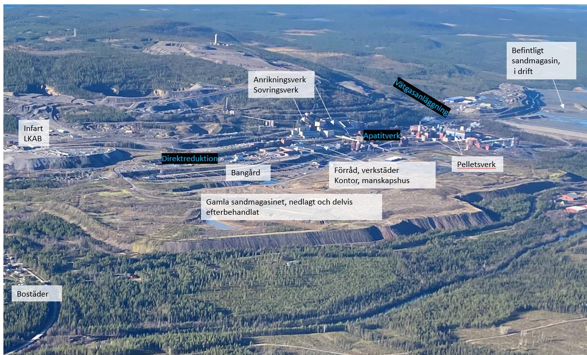
Figur 4. Drönanvy över Vitåfors industriområde sett från öst med beskrivning av befintliga anläggningar och funktioner samt med ungefärligt läge för direktreduktionsanläggningar och vätgasanläggning markerade.
