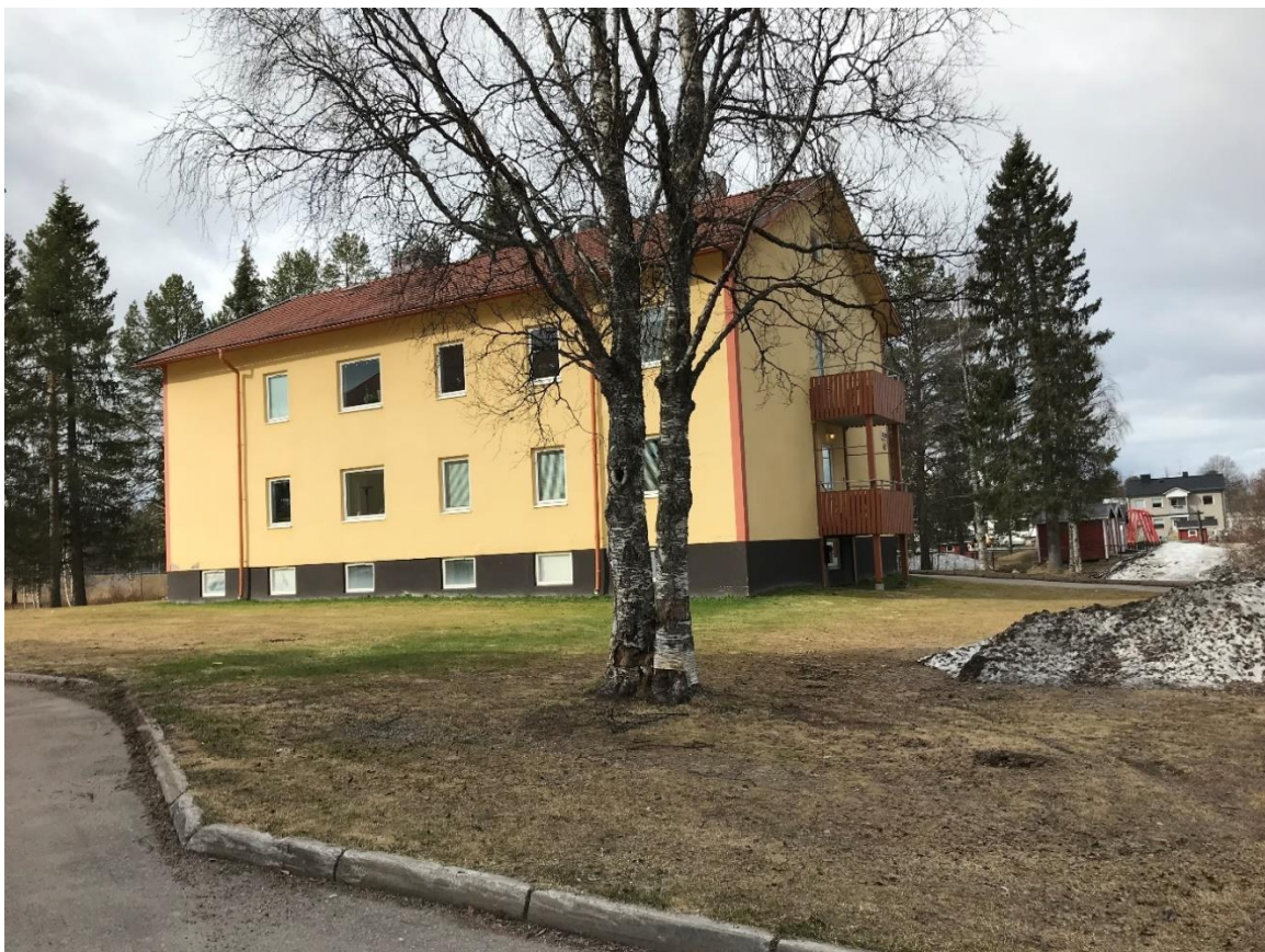
Figur 13: Byggnad i den västra delen av planområdet.
