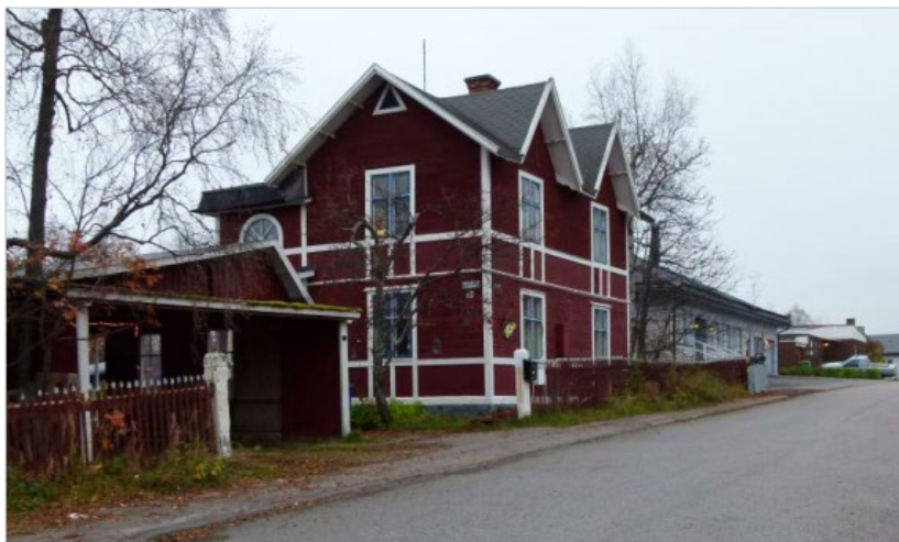
Figur 10. B111, högt värde. Denna byggnad kommer att flyttas till ny lokalisering.
