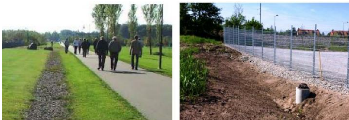
Figur 23. Exempel på svackdike. Svackdiken kan vara gräsbeklädda men kan även bestå av grusfyllning. Dikena fungerar både som infiltrationsyta och öppet avrinningsstråk och har beroende på utformning, mer eller mindre förmåga att fördröja dagvattnet.
