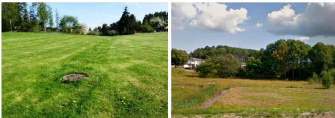
Figur 22. Exempel på översilningsyta/torrdann. En översilningsyta är en lätt sluttande gräsyta dit vatten från vägar och andra hårda ytor leds. Vattnet renas när det sprids över gräsytan och filtrerar ner i jorden. För att skapa fördröjning regleras bräddnivån med exempelvis en brunn.
