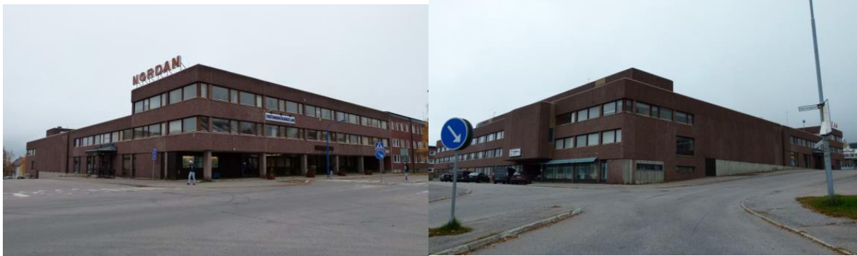
Figur 10. Folkets hus Nordan från 1973. Källa: Tyréns 2017
