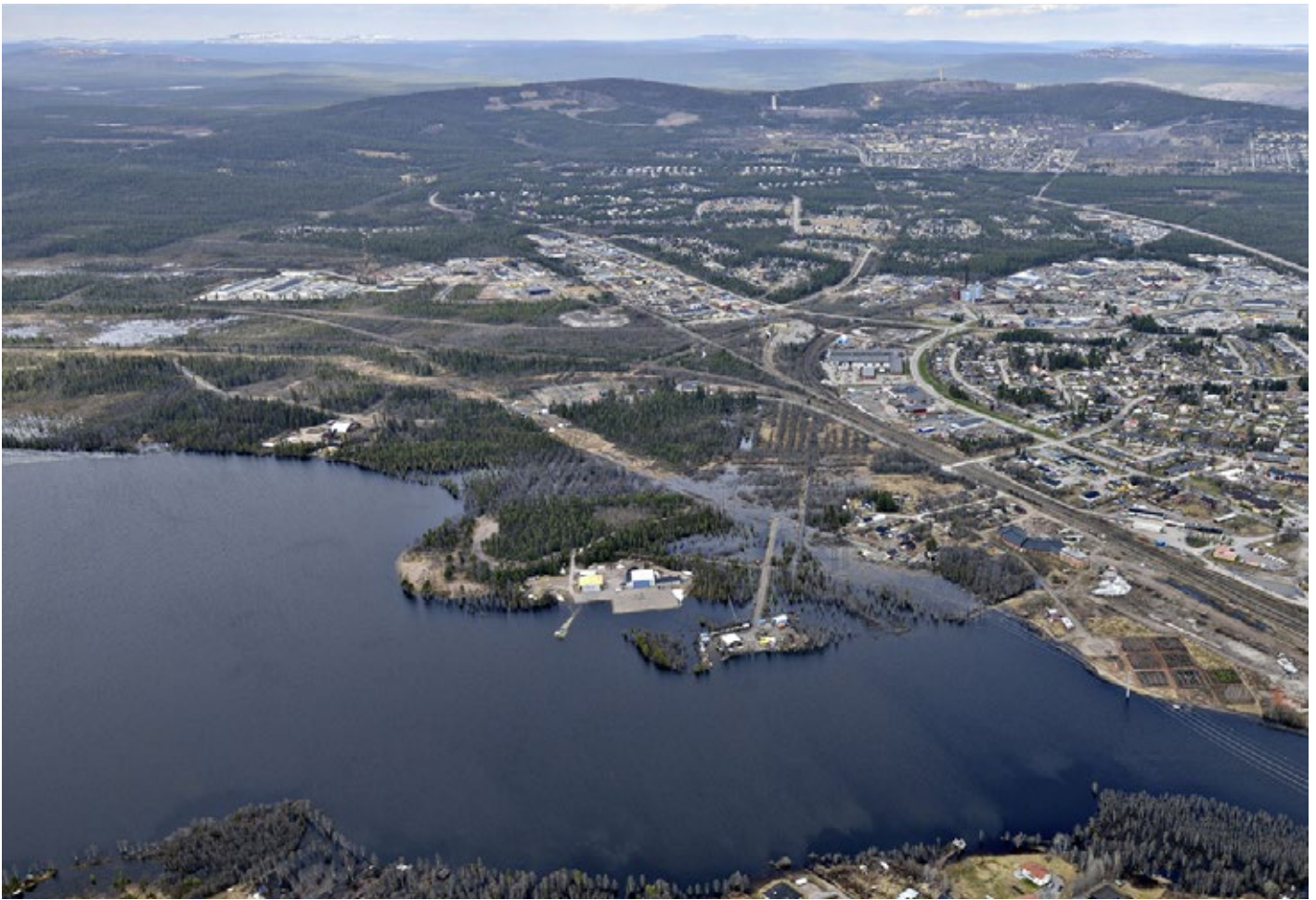
Figur 13. Området för utvecklingsplanen vid senaste större översvämningen 2012. Där framträder tydligt de infrastrukturanläggningar som är säkrade för översvämning vilket ger området ett karaktäristiskt utseende av bryggor och spänger som varit vägledande i utvecklandet av planens koncept.
