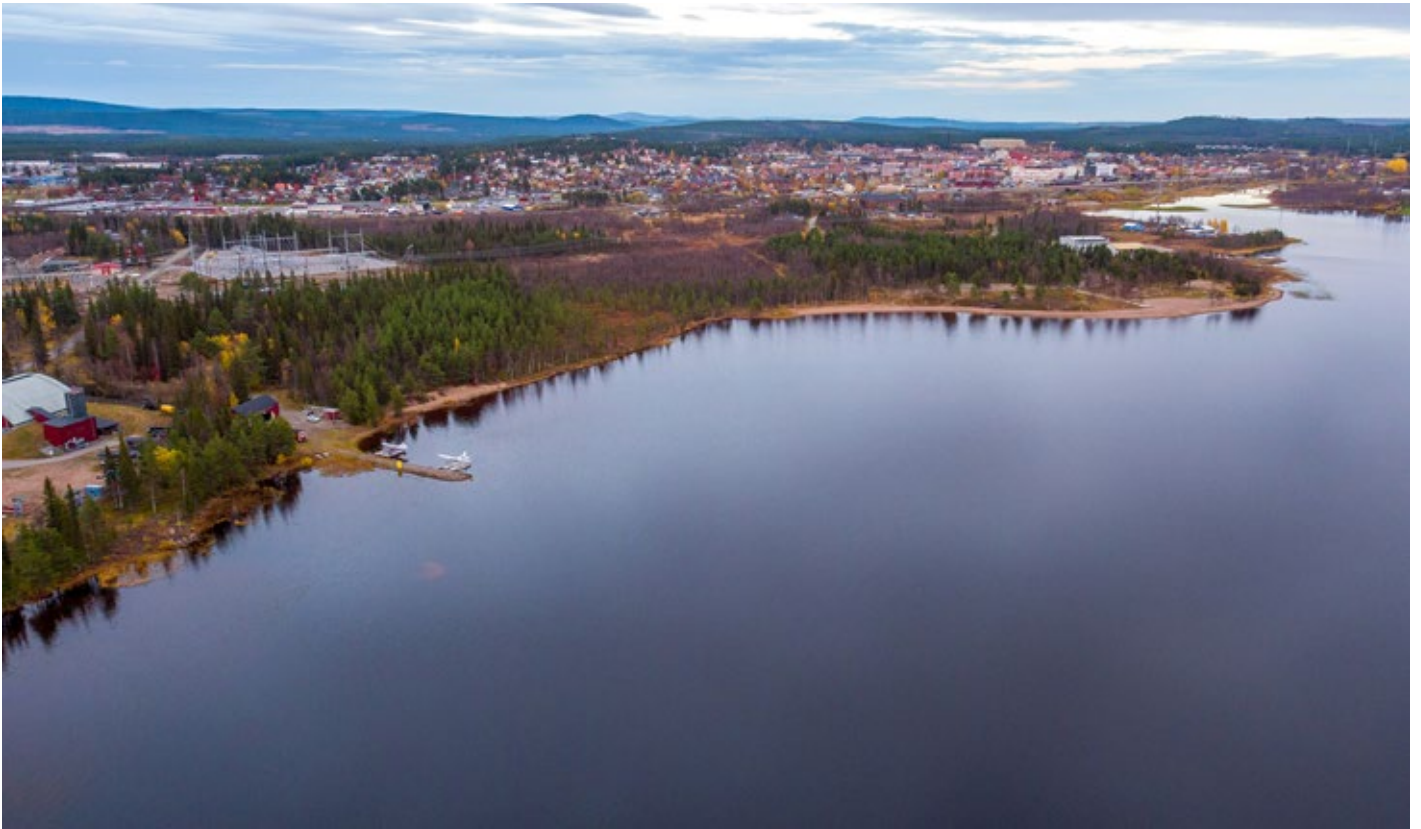
Figur 1. Flygfoto som visar de östra delarna av projektområdet.
