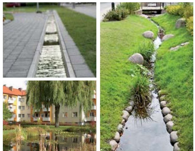
Lokalt omhändertagande av dagvatten i kanaler på gata, damm på innergård och kanal på innergård.
