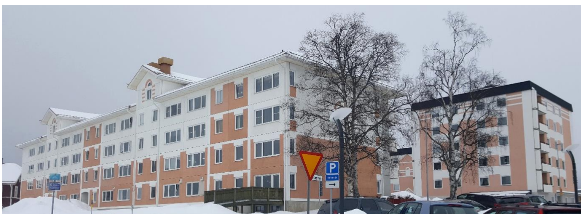
Figur 11 Flerbostadshuset på kvarteret Engelsmannen i södra delen av planområdet. (Foto: MAF Arkitektkontor, mars 2017)
