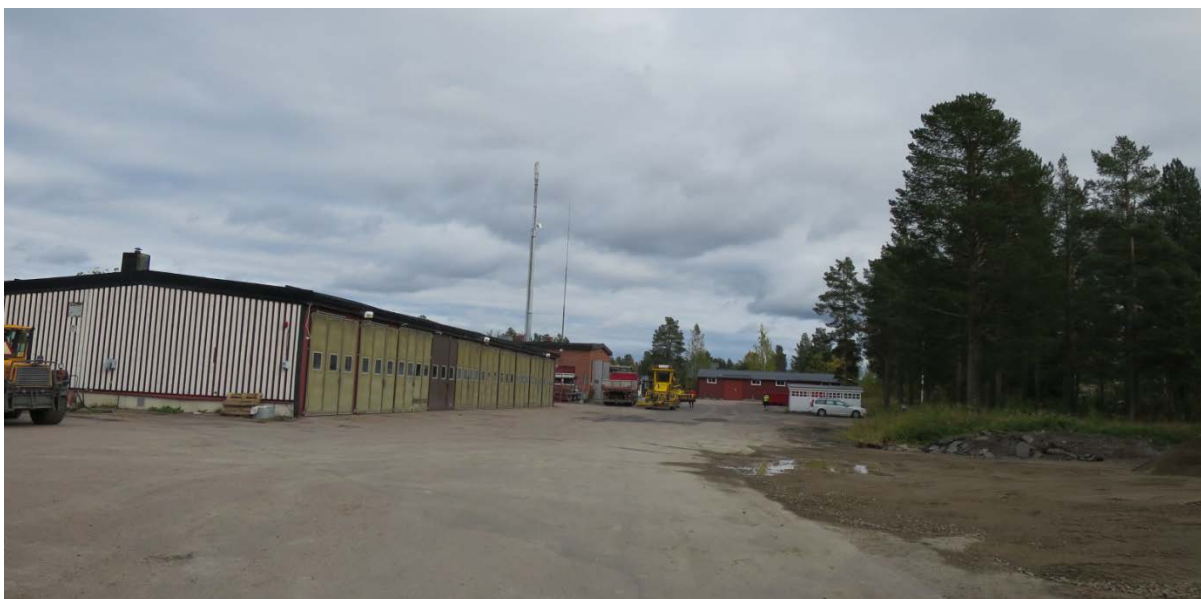
Figur 10. Befintliga hallar inom planområdet. Kommunikationsmasten som flyttas syns i bakgrunden.
