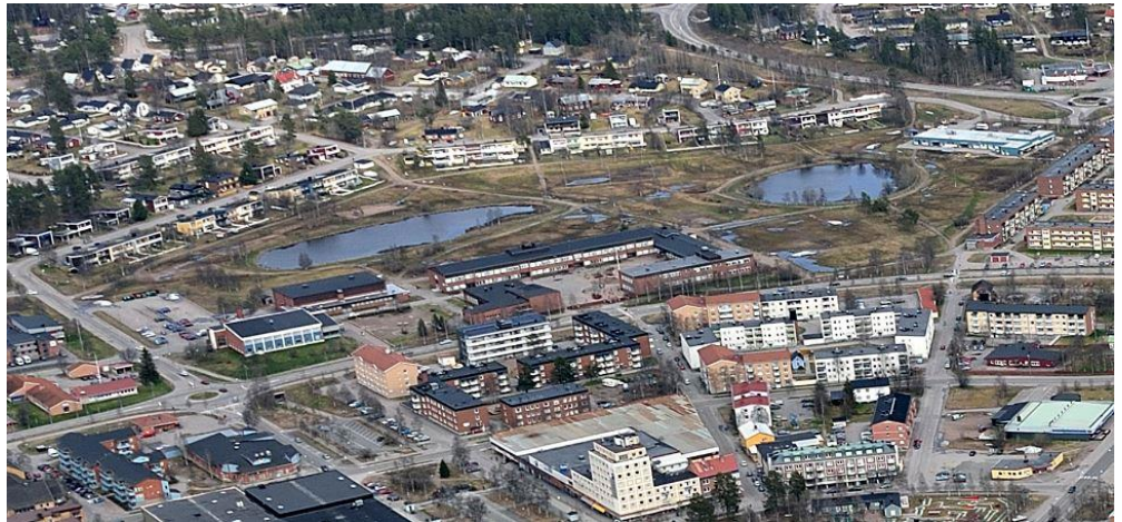
Figur 5. Höga vattenstånd i Junkkatjärnarna i samband med snösmältning, området mellan tjärnarna är synligt blött. Källa: Gällivare kommun.
