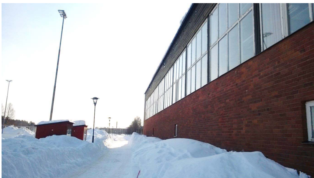
Figur 14. Sporthallens norra fasad som den nya is- och evenemangsarenan ska byggas ihop med.
