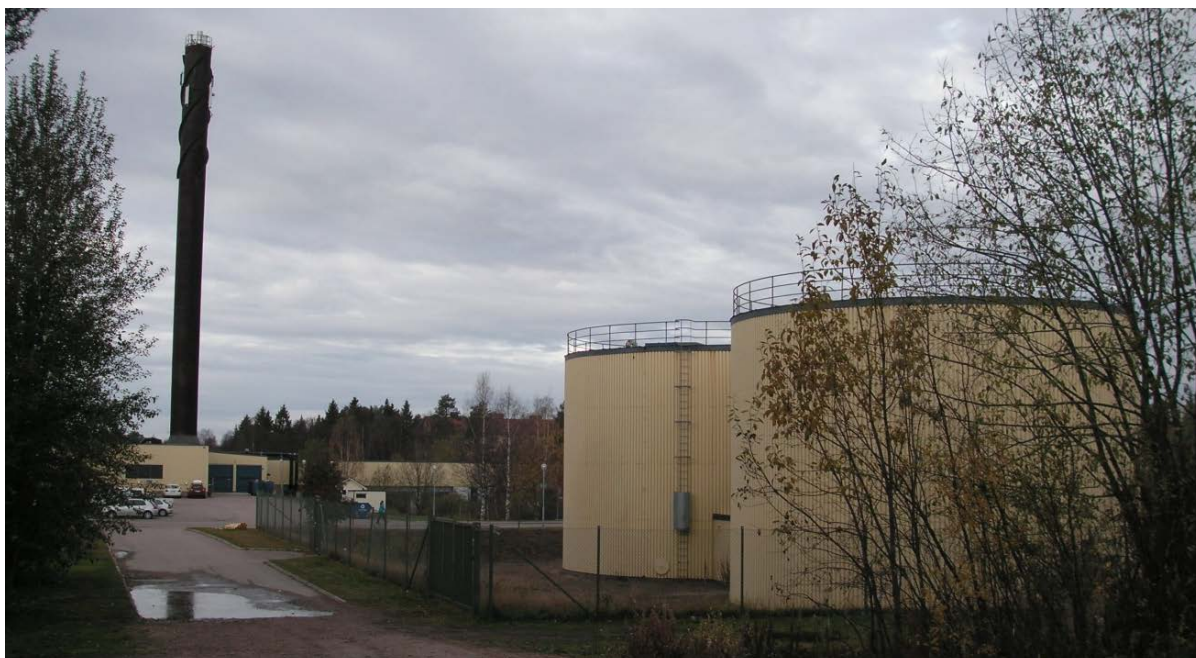
Figur 10. Oljecisternerna med panncentralen i bakgrunden. Foto: MAF 2014.
