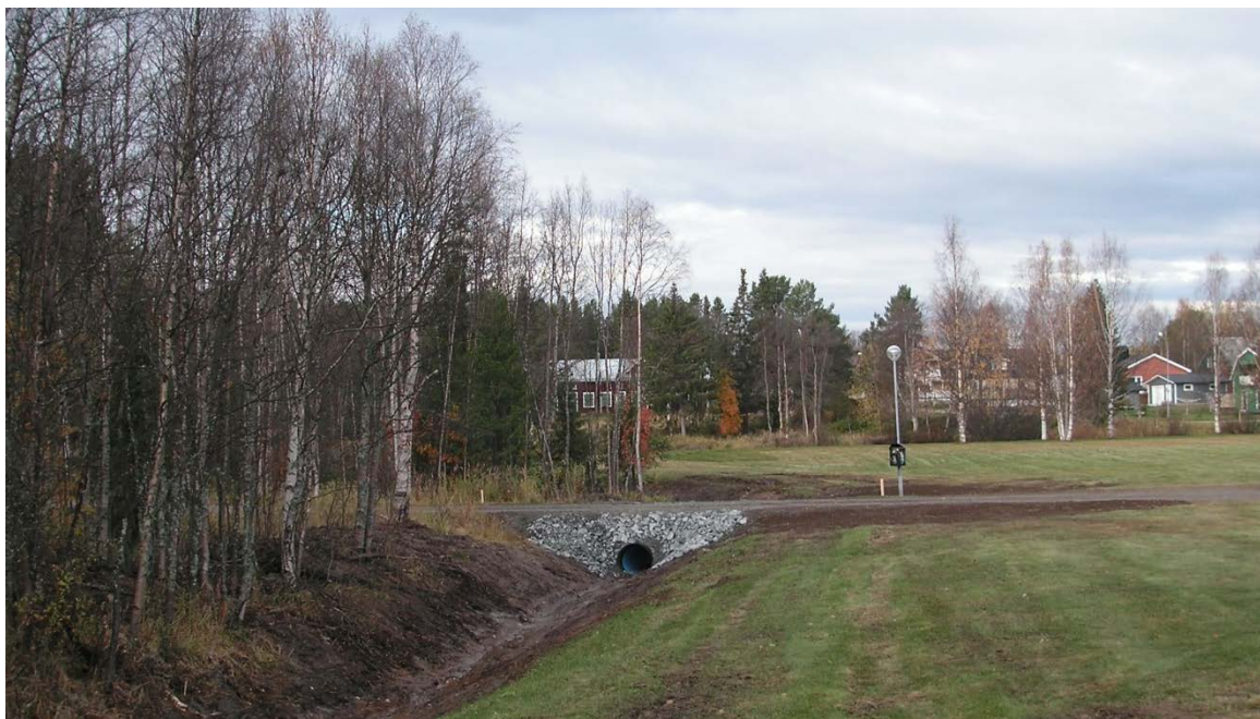
Figur 5. Ett nyanlagt dike med vägtrumma för dagvattenavrinning mot Vassaraälven. Foto MAF 2014.
