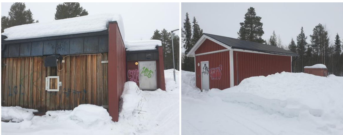
Foton på teknikbyggnaderna inom Gällivare 14:29 (Källa: Gällivare kommun 2020-03-13)
