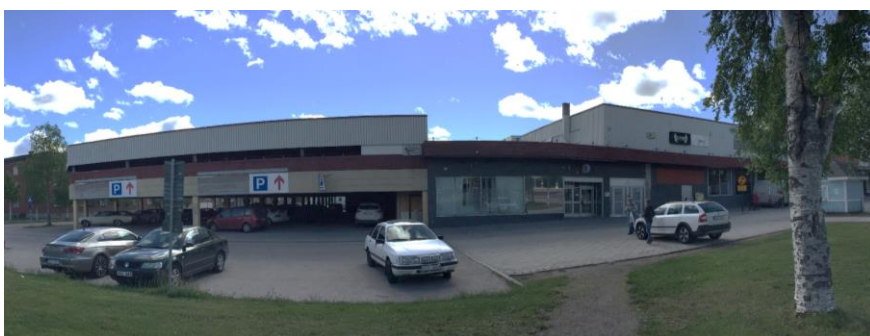
Foto visar befintlig byggnad inom planområdet (Foto: Johanna Söderholm, Tyréns AB, juni 2017)
