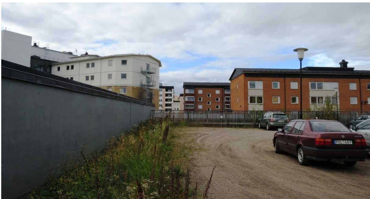
Figur 5. Befintliga suterränggarage på närliggande fastigheter syns sticka upp.
