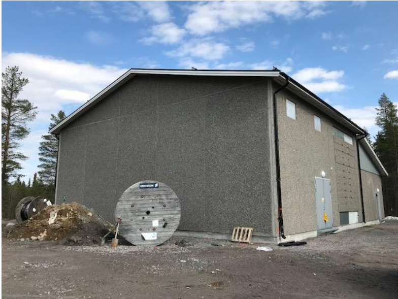
Figur 5. Foto tagen från befintlig infart och visar transformatorstationens västra och södra fasad.
